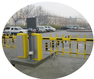
出入闸口区域
