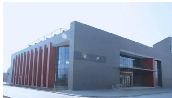
餐厅：已安装部分烟感、部分烟感老旧无法继续使用
