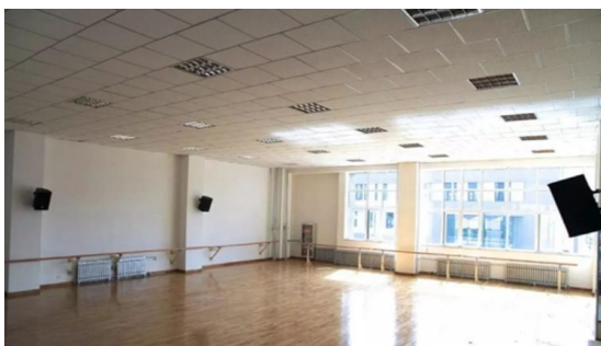
舞蹈系：走廊内安装部分烟感、教室、更衣室、办公室内均未安装
