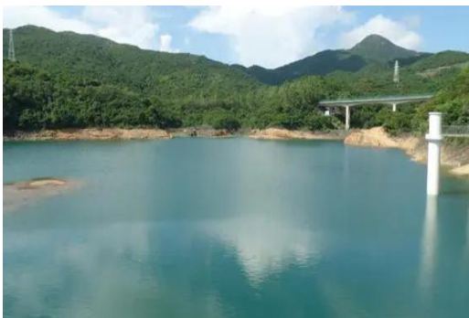
水库大坝视频监视
