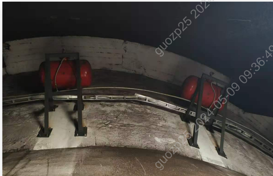
空气炮安装后
