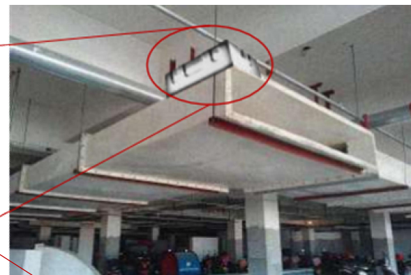
选择平放并固定在通风/电路管道上方
