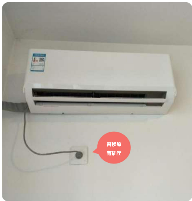
壁挂空调控制器安装示意
