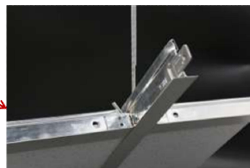
室内装修常见的矿棉吊顶及T形龙骨示意图
