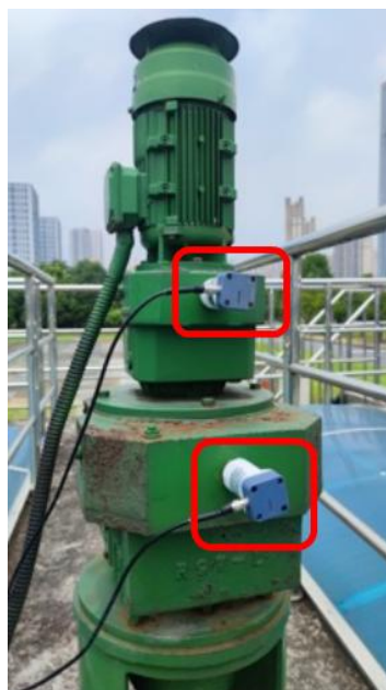
搅拌机安装点位
