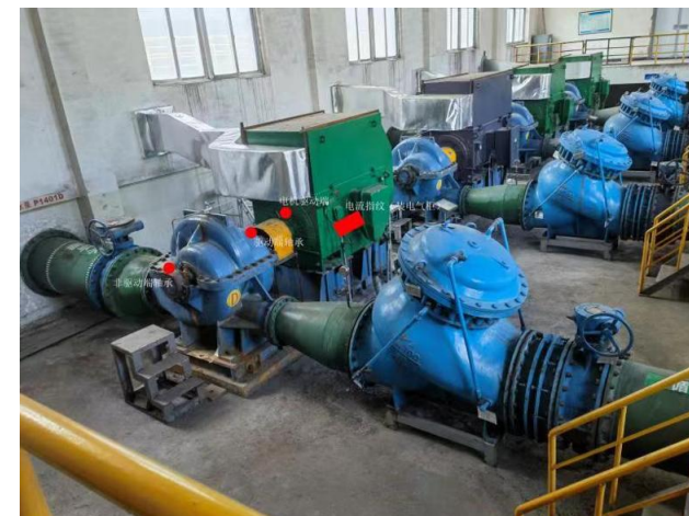
高压循环水泵安装点位
