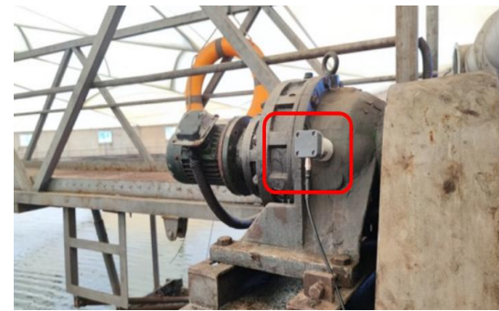
刮泥机安装点位
