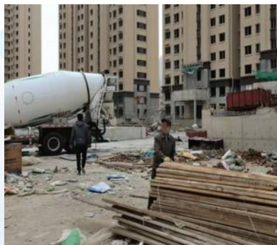
现场、人员检查
