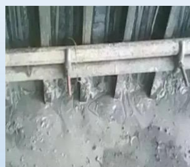
浇筑漏浆检查
