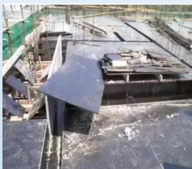
模板安装质量检查
