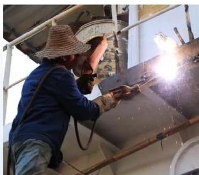
明火作业检查
