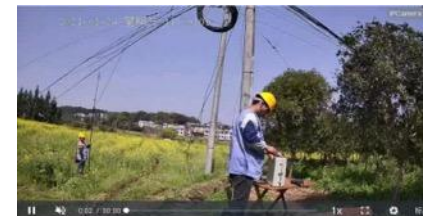
施工视频记录
