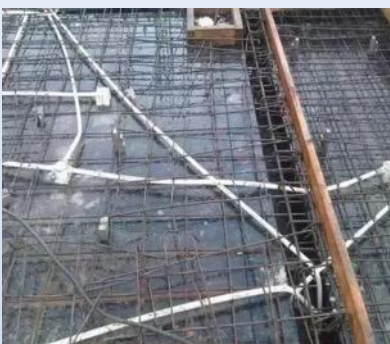
钢筋绑扎质量检查
