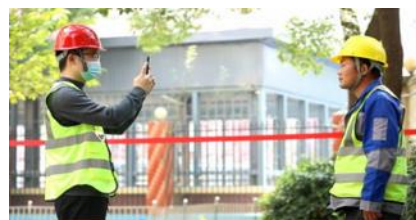
施工人员管理
