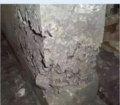
混凝土缺陷检查
